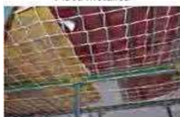
Red reutilizable anclada en placas metálicas
