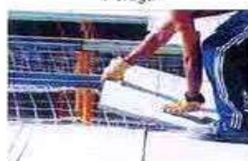
En tablado con la red instalada
